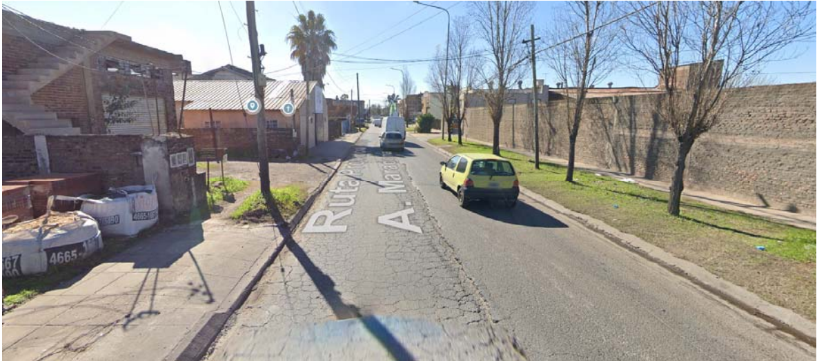
Imagen 3. Deterioro en R.P. N° 4 (Camargo). Partido de Hurlingham.
